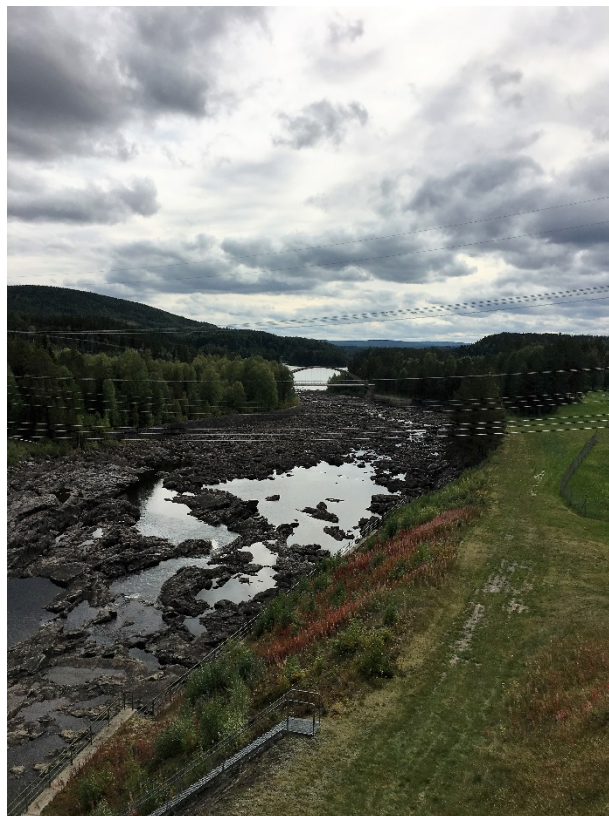
Lasele kraftstation den 5 september 2017.
